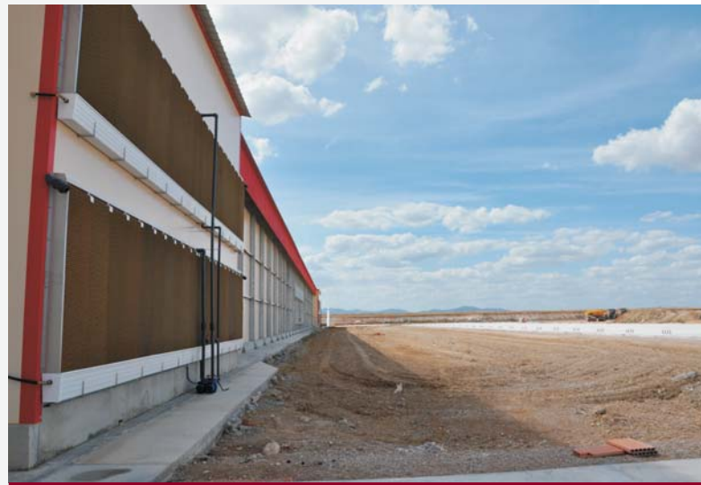
Uno de los laterales de la instalación, donde se puede apreciar el terreno en el que se construirán las dos próximas naves.
